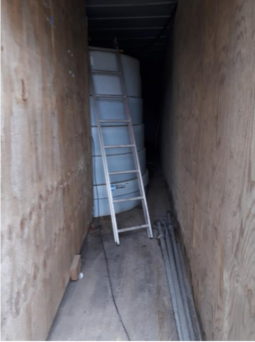
Billede 1: Beholder til AdBlue i aflåst container med opsamlingsbakke
