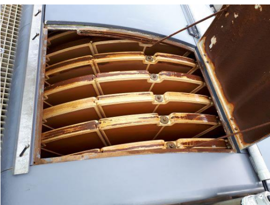
Mikrofiltrer til fjernelse af SS.
