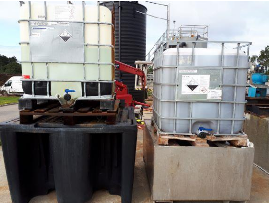
Saltsyre og natriumaluminat til henholdsvis rensning af mikrofiltrere og fældning. Med opsamling af evt. spild.
