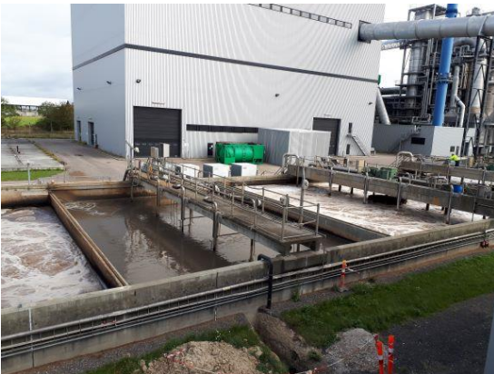
Beluftning gammelt anlæg.
