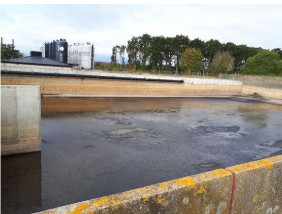
Gammel udløbsbassin, som anvendes til returskyllning af kulfiltre.
