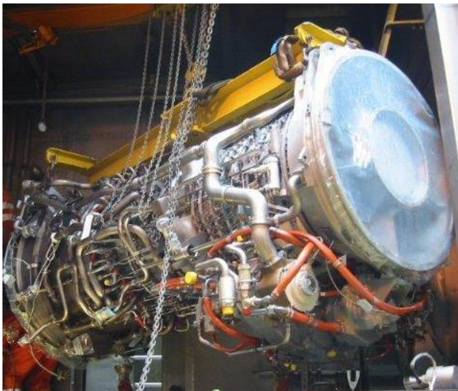
Figur 1 Billede fra turbineudskiftning
