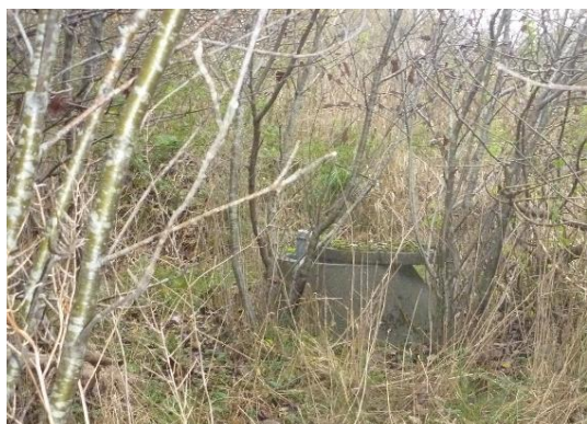
Figur 5: SKIII fjernes, da den ikke anvendes til pejling mere. Boringen består af et pejlerør lukket med prop, og med en stor cementring med låg omkring.
