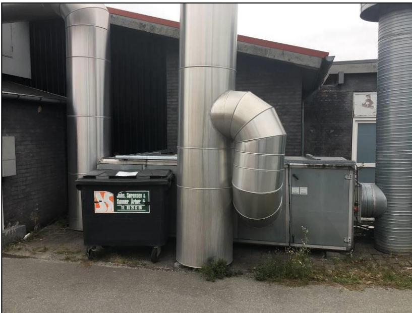
Foto af rumsug og varmegenindvindingsanlæg
