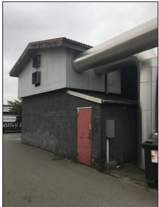
Foto af rumsug og varmegenindvindingsanlæg
