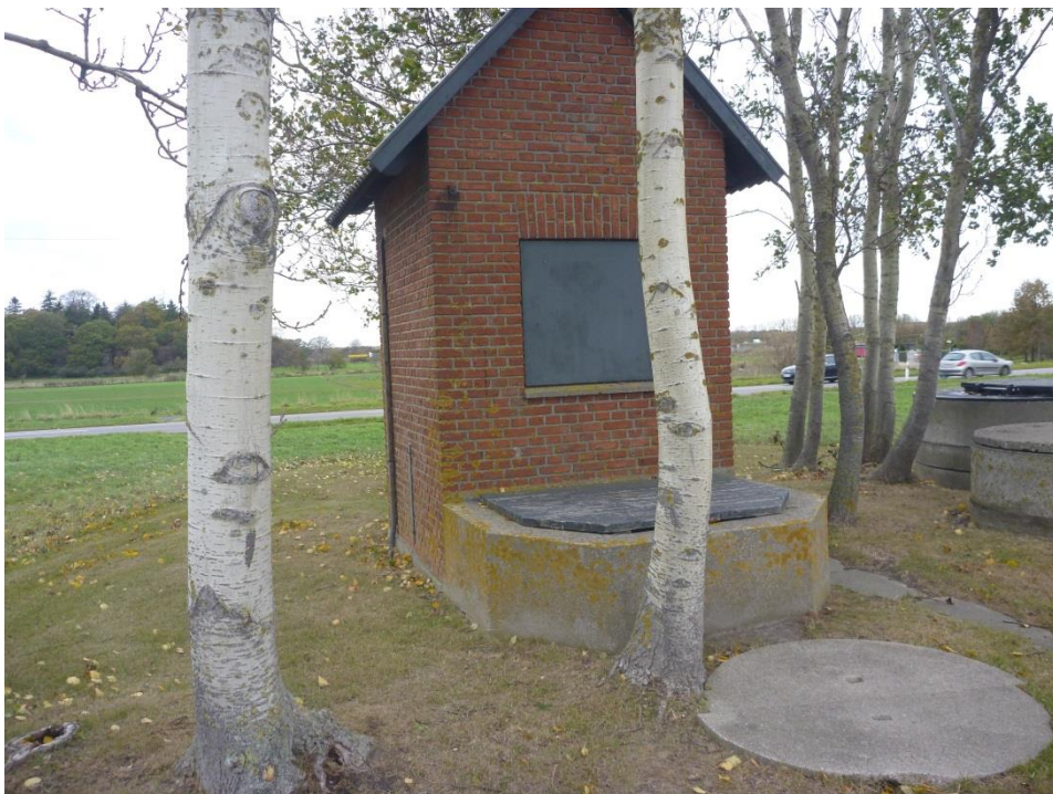
Figur 8. Pumpestation (P2) for overfladevand fra den sydlige del af nærtliggende industriområde
