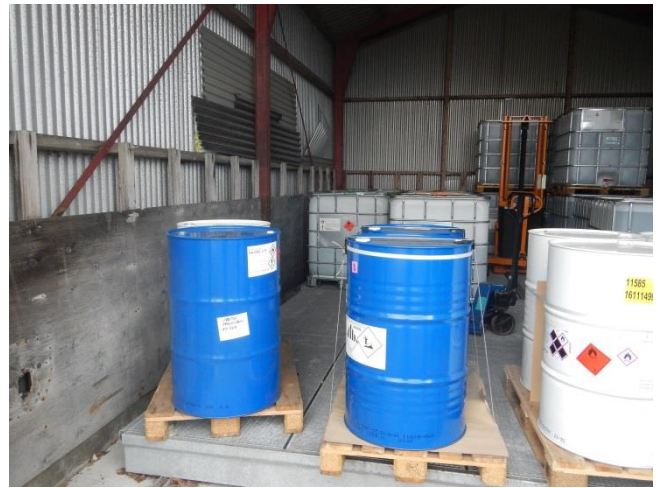
21. Oplagsrum for brændbare væsker. Beholderne står på elefantriste på opsamlingsbeholder med stor opsamlingskapacitet.
