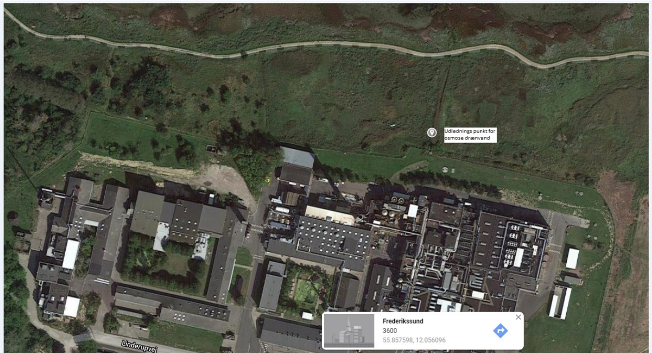
Figur 3 Oplyst udlædningspunkt for osmosevand og overløb til ved ekstreme regnhændelser.
