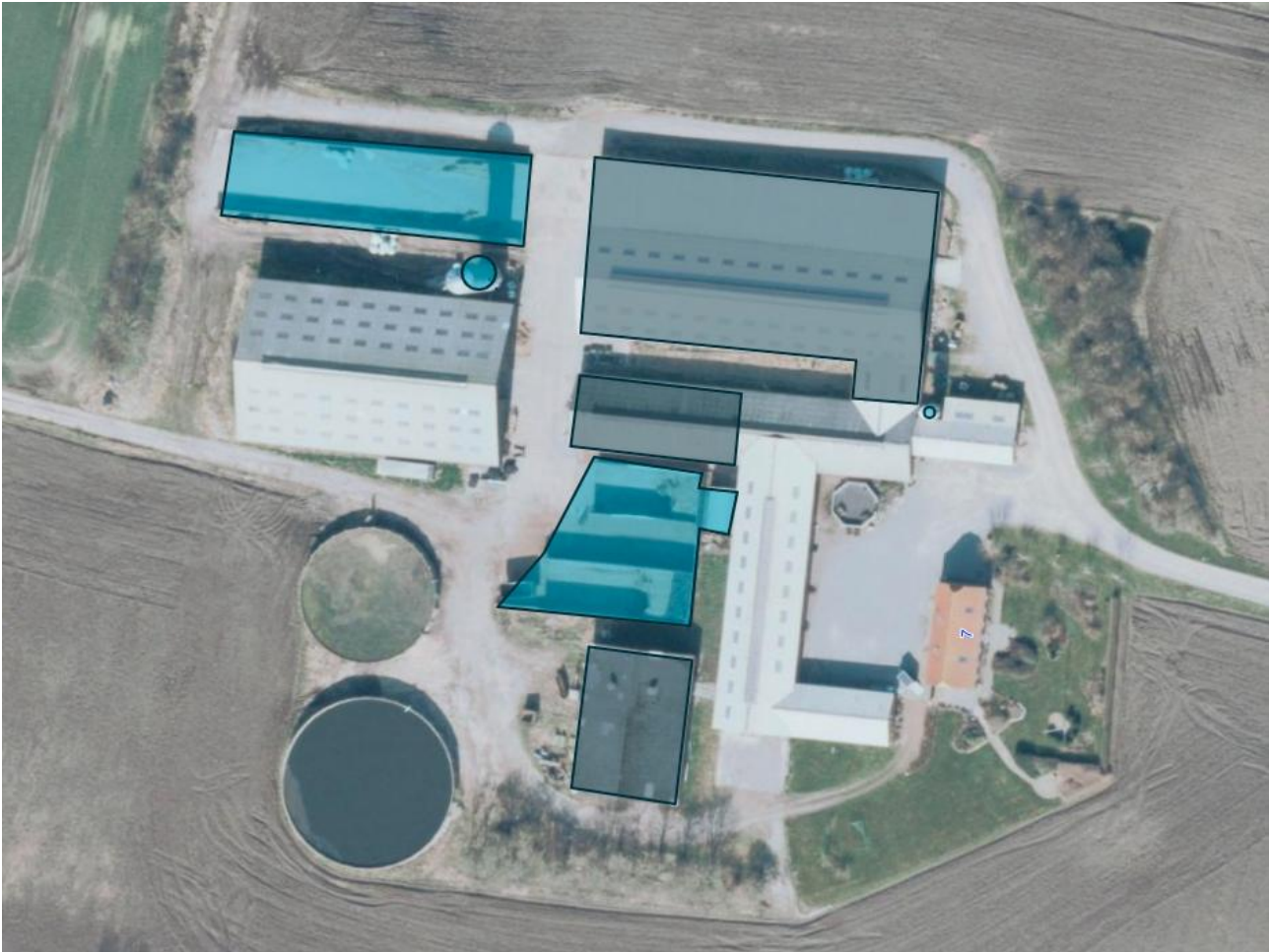
Figur 1. Markering af bygninger og siloer det er planlagt der fjernes.
