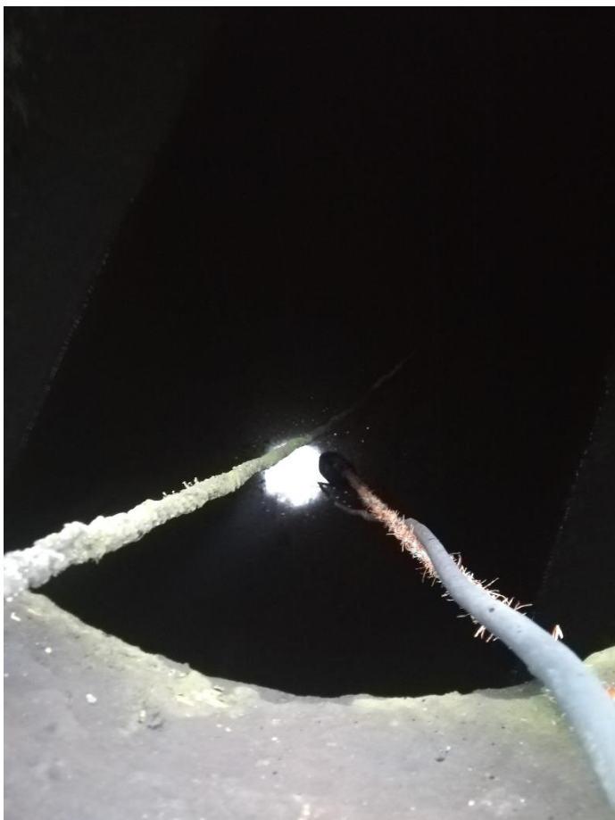
Billede - Der står vand i perkolattanken. Vandet pumpes op fra deponiet til tanken, hvorfra det føres til renseanlæg.
