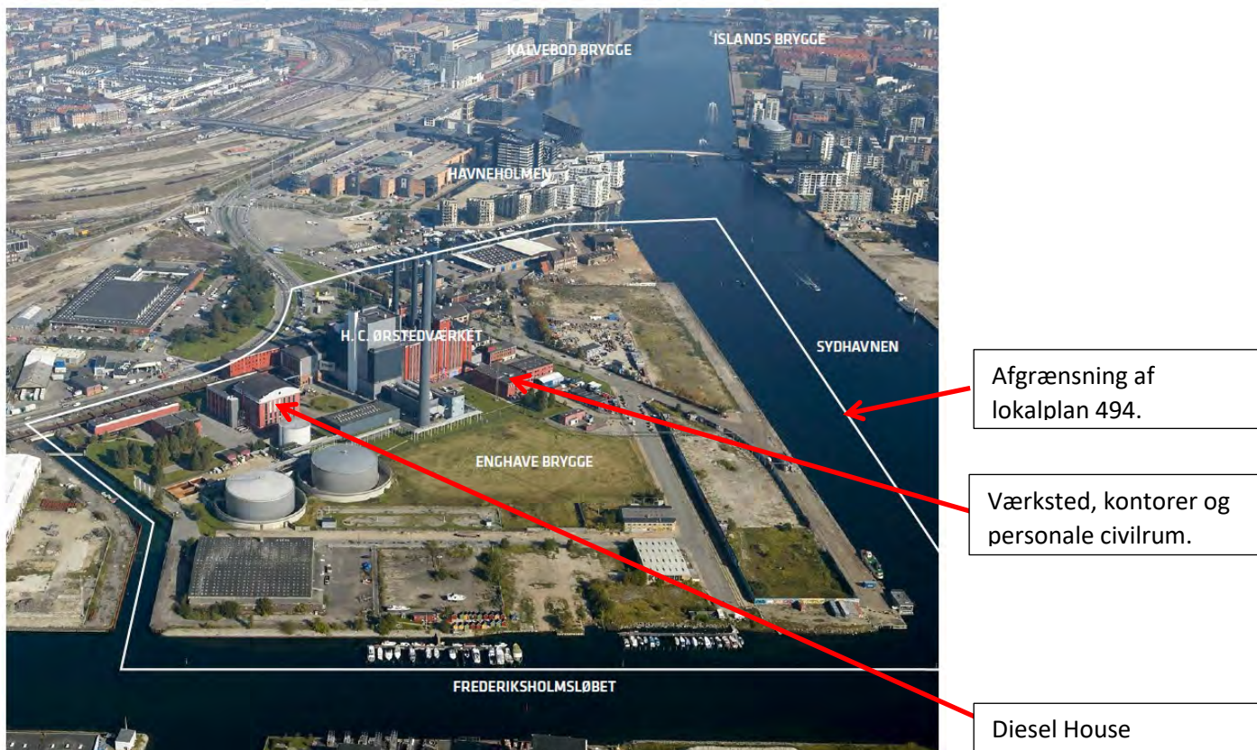
Figur 6. Luftfoto af Enghave Brygge set mod nord. Havneholmen, Fisketorvet, Kalvebod Brygge. Bane arealerne samt Islands Brygge ses i baggrunden. Hvid streg viser afgrænsning af lokalplan 494. Kilde: Lokalplan 494.
