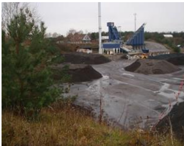
Asfaltanlæg og oplag af stenmaterialer og knust genbrugsasfalt
