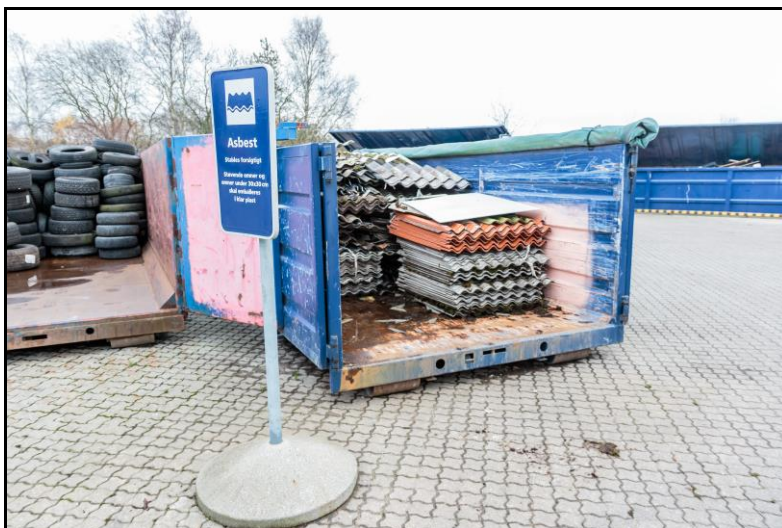
Foto 4 Opbevaring af eternitplader
