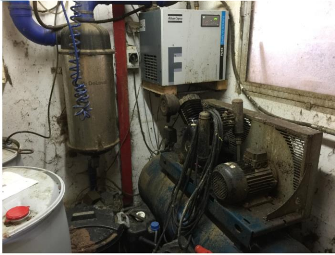
Vacuumpumpe til malkeanlæg
