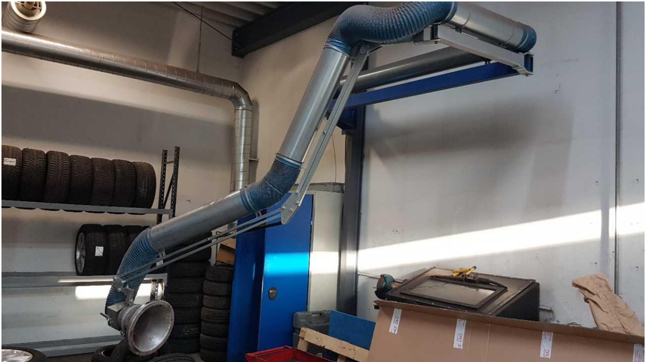
Udsugning til div. aktiviteter som slibning, rensning af bremses m.m.
