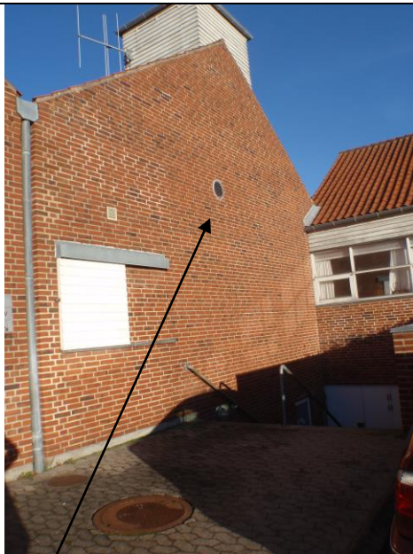
Afkast for udsugning af udstødningsgasser.
