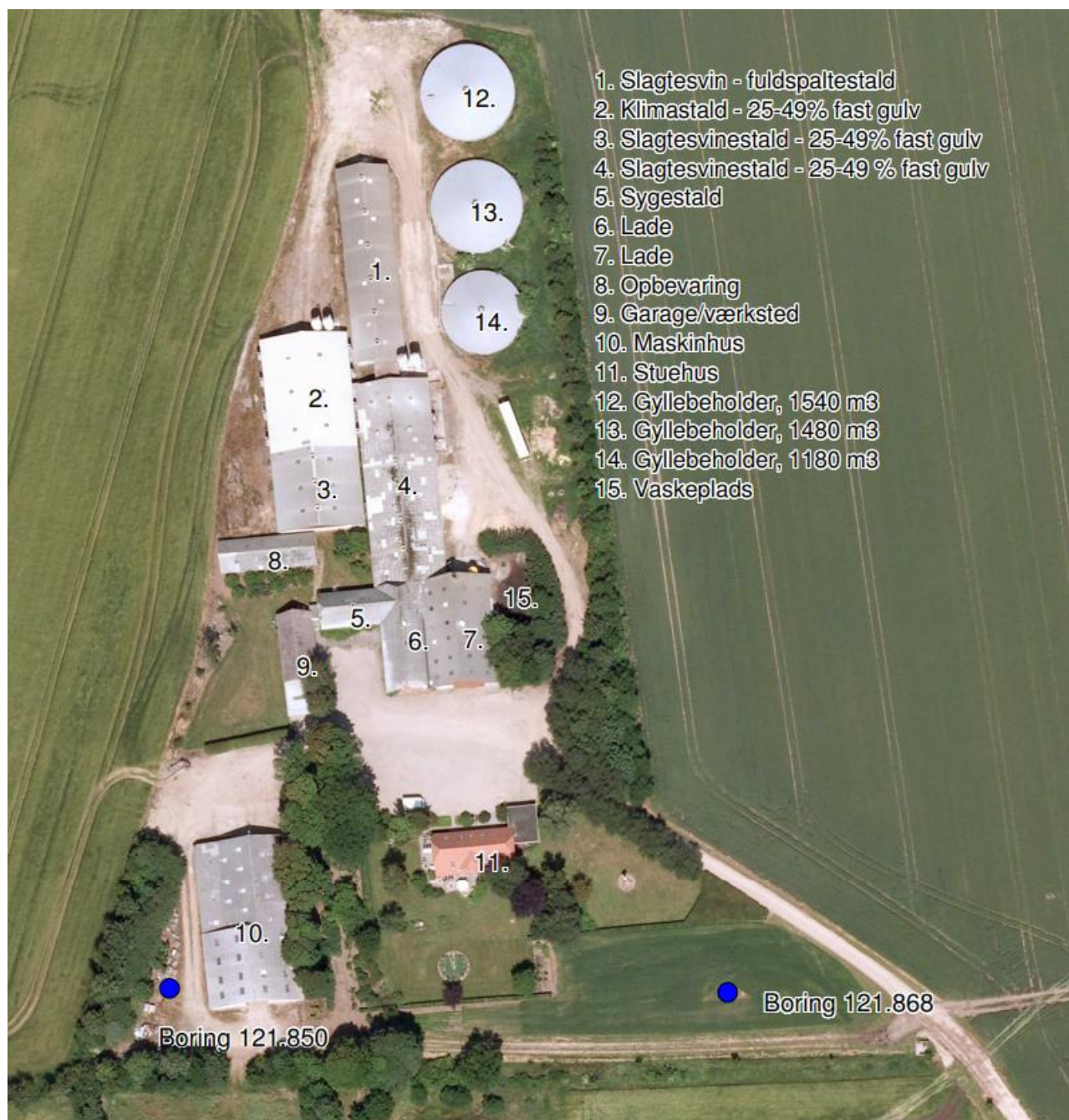
Figur 3. Oversigt over husdyrbrugets bygninger.
