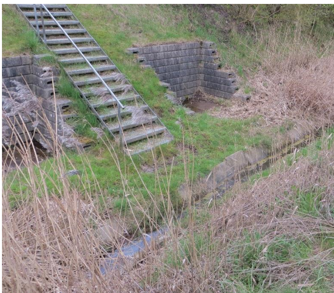
Figur 2: Drængrøft i deponiets vestlige ende.
