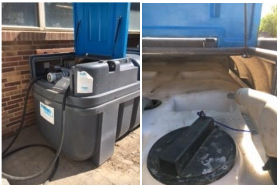
Billede 2. Dobbeltvægget 2000 Liter Strongblue AdBlue tank DW, tanknr. 344 SB fra Strong Blue A/S.
