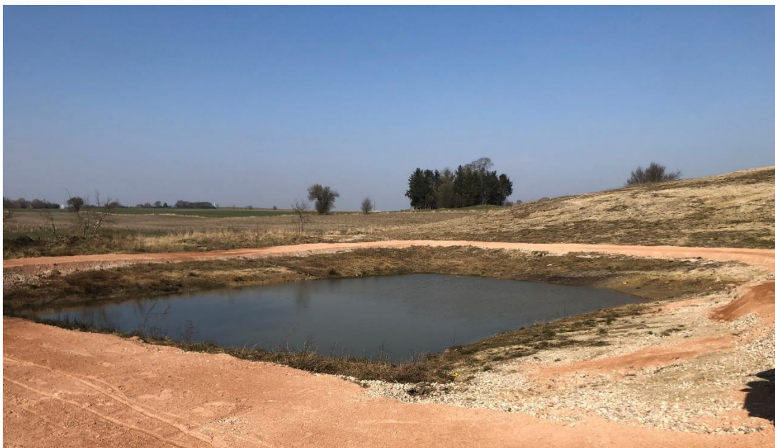
Billede 4. Billede af regnvandsbassin taget ved tilsyn den 21. marts 2022.
