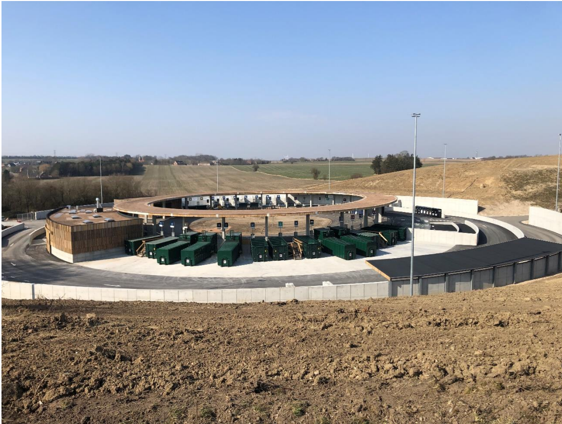
Billede 1. Billede over genbrugspladsen taget ved tilsynet den 21. marts 2022.
