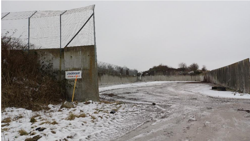
Foto 4. Celle 1. Skilt udenfor cellen angiver jorddepot, som kun må anvendes i tilfælde af brand i affald i cellen.
