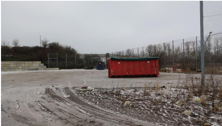
Foto 5. Plads til oplag, neddeling sortering af brandbart affald. Pladsen var tomt.
