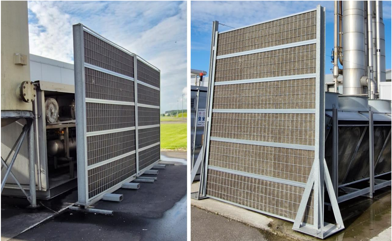
Figur 3.1: Støjskærme opført efter tilsyn.
