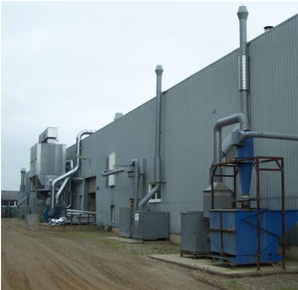
Afkast placeret syd ved produktionsbygningens sydlige facade.
