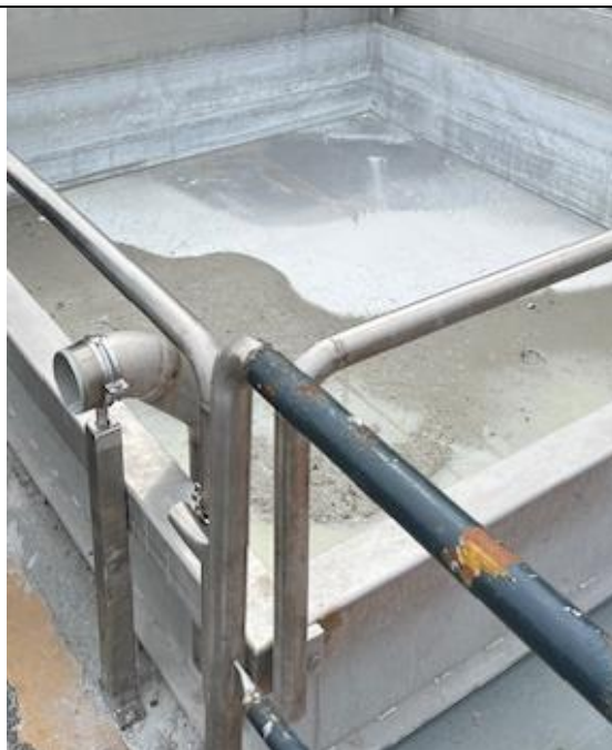
Foto 2 Østlig del af skråbassinet, med stålindsats
