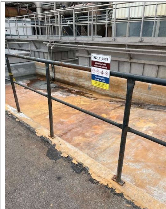
Foto 1 Skråbassin (den del med skrå bund)
