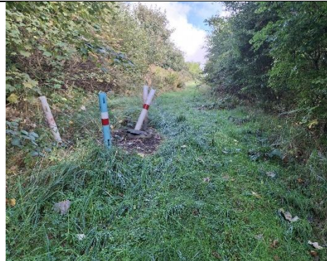
Markering af brønd for at forhindre påkørsel
