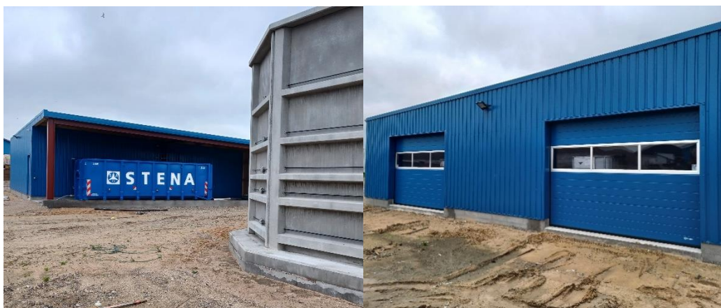
Billede 4: på billedet til venstre ses den grå silo/buffertank, med bygningen til renseanlægget i baggrunden. Containeren til spildevandsslam kan ses på billedet. Til højre ses portene ind til spildevandsrenseanlægget. Portene bruges kun til at levere materialer til anlægget. Det kan også ses at der på arealet endnu ikke var etableret belægning.
