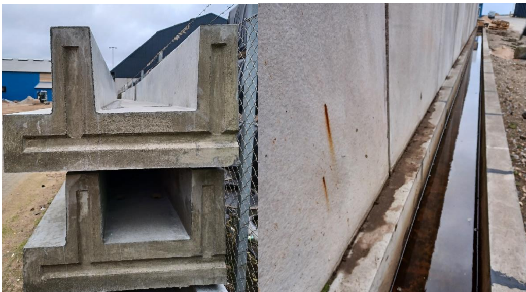
Billede 5: På billedet til højre ses beton modulerne til spildevandsrenderne. Til venstre ses en spildevandsrende etableret med betonelementerne.
