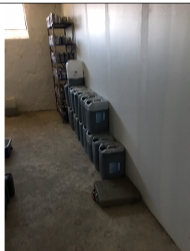
Brandsikret rum i kælderen
