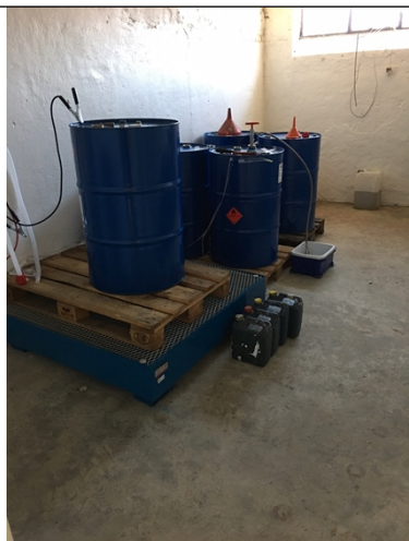
Brandsikret rum i kælderen
