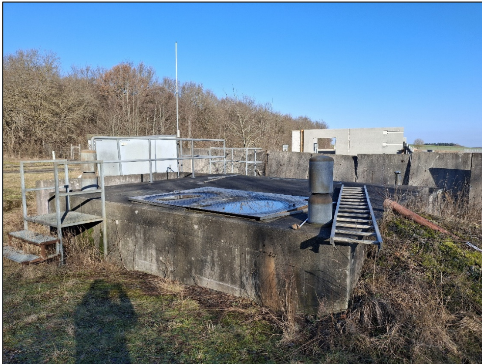
Foto 4: Perkolatsamlekar, hvorfra perkolat og sekundært drænvand ledes til kommunalt renseanlæg.
