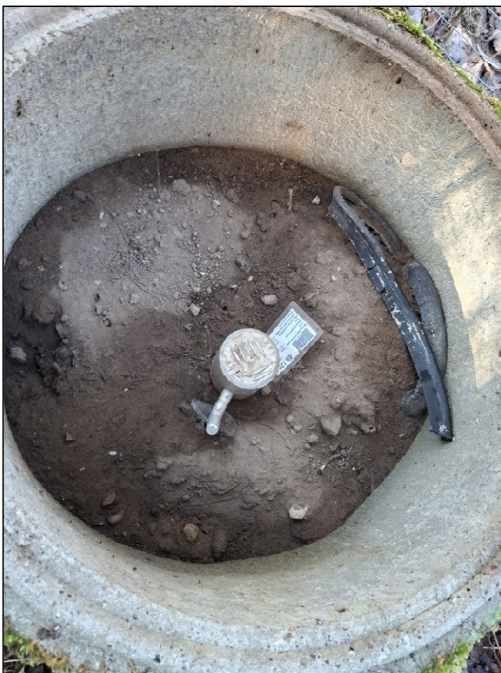
Foto 11: Grundvandsmoniteringsboring 61 (primært grundvandsmagasin)
