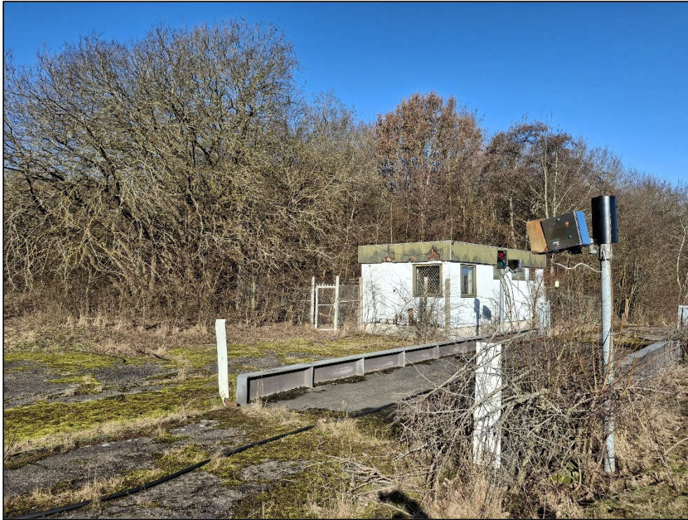
Foto 13: Mandskabsskur og vejebod ved indkørsel til deponiet.
