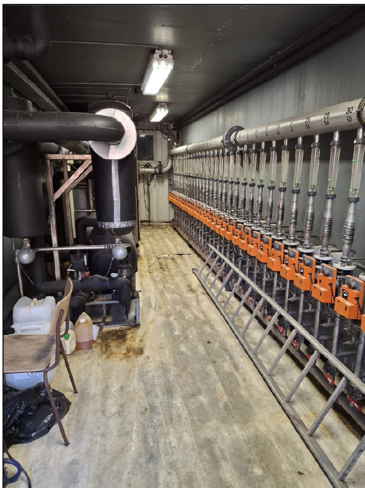
Foto 8: Gasindvindingsanlæg.
