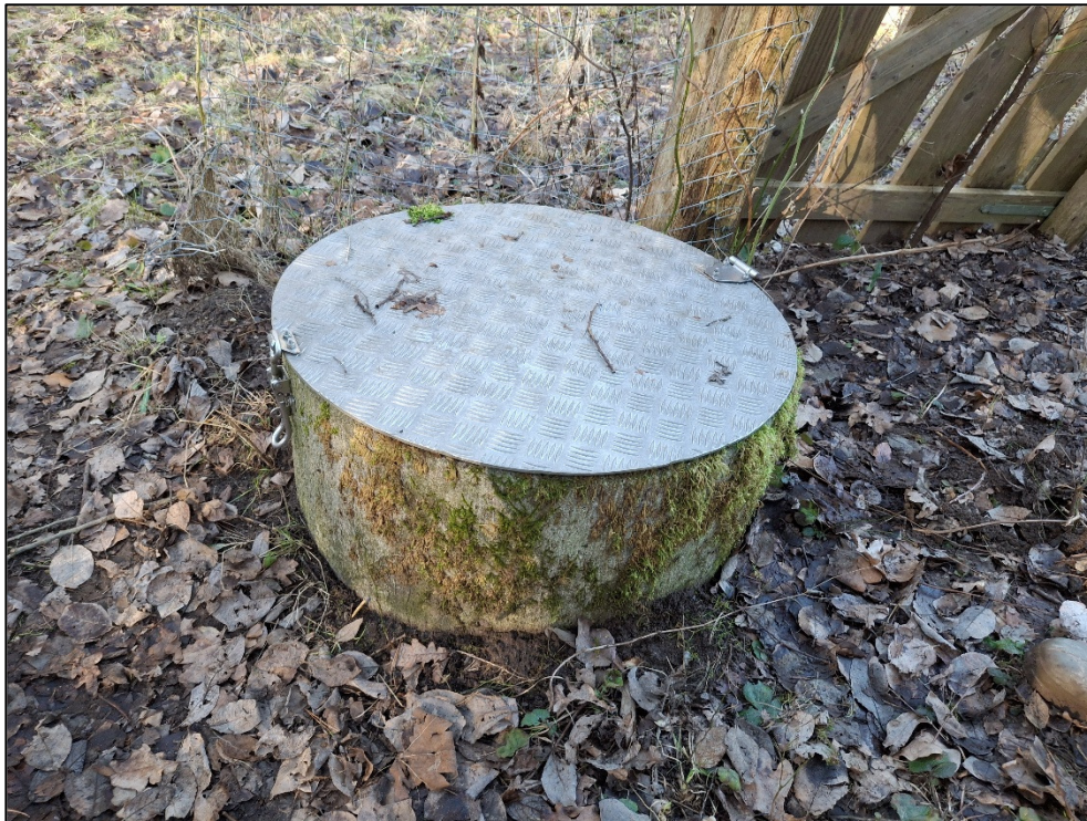
Foto 10: Grundvandsmoniteringsboring 61 (primært grundvandsmagasin)
