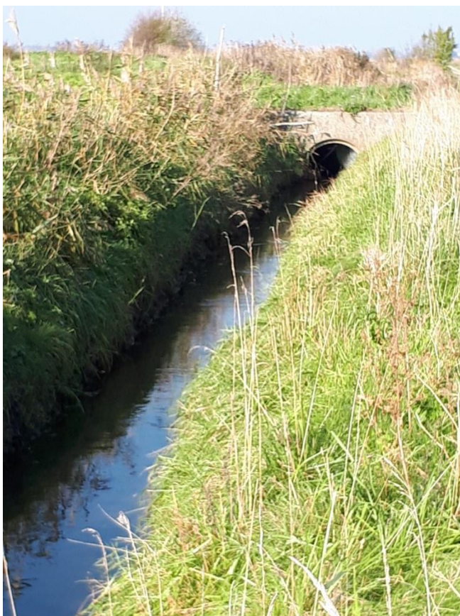
Ovenstående billede viser Svanholmgrøften på deponiets østlige side. Grøften er stedvis rørlagt.
