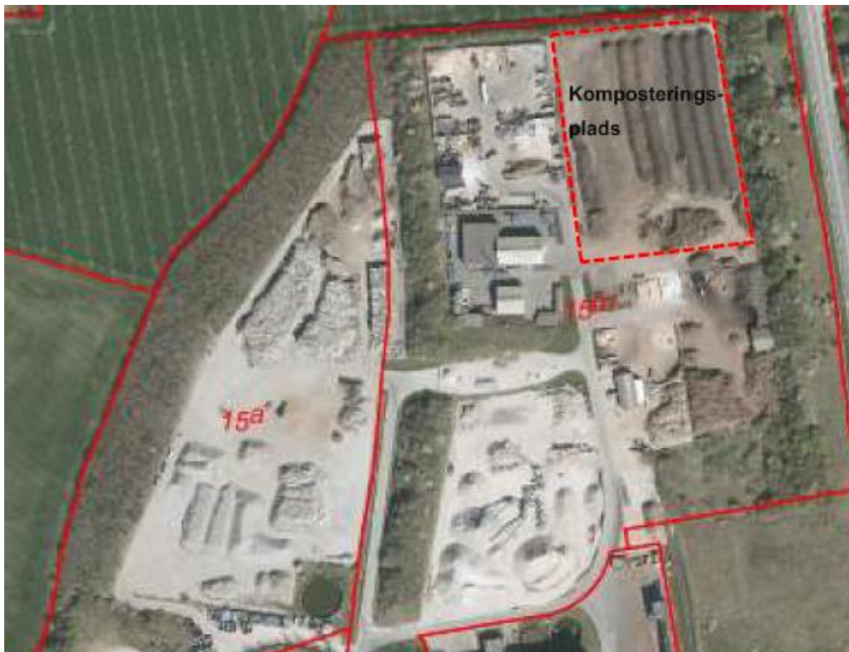
Luftfoto af den nordlige del af Affaldscenter Aarhus
