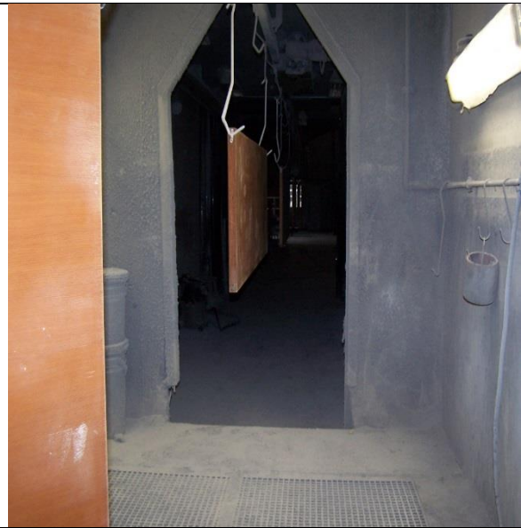
Overfladebehandling i den ”lukkede tunnelhal” med syrehærdende/opløsningsmiddelbaserede grunder/lakker
