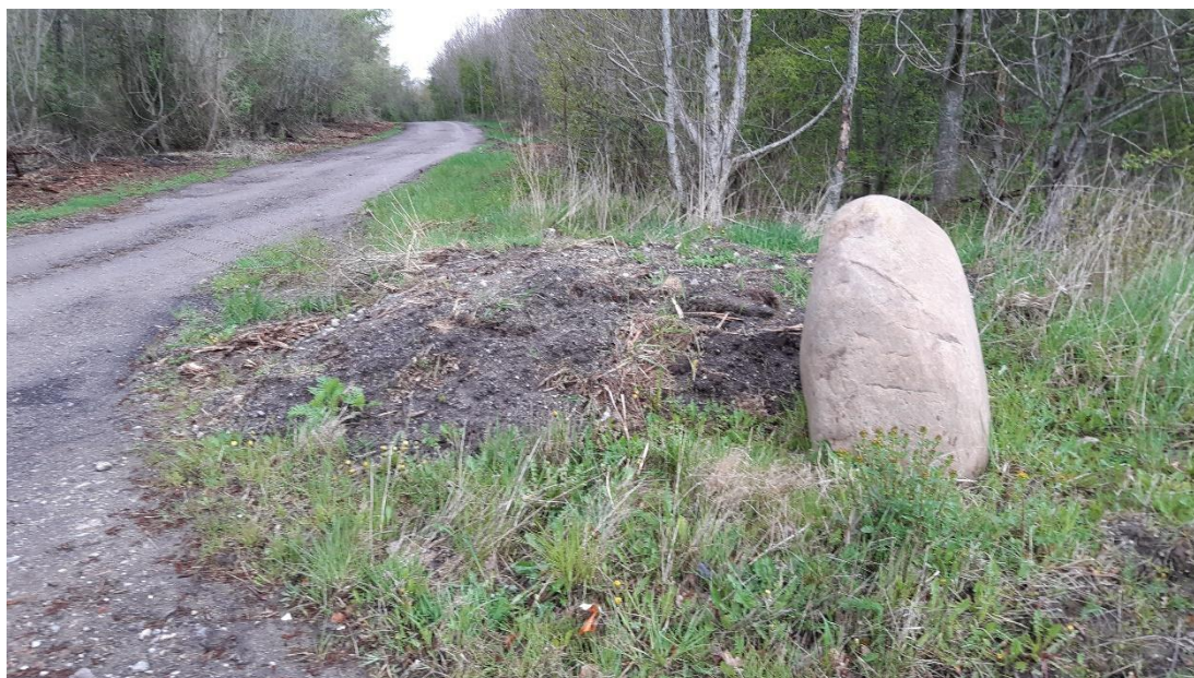
Figur 1. Afdækket gravehul på etape 1.
