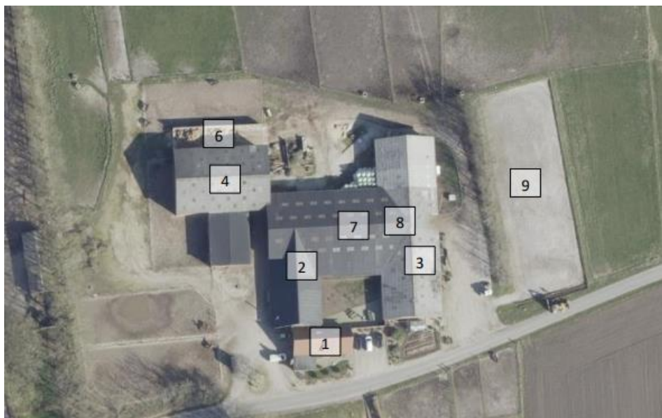
Figur 7 Oversigt over husdyrbrugets bygninger på Østerlundvej 22, undtagen læskur mod nordøst.
