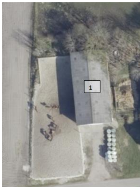
Figur 8 Oversigt over husdyrbrugets bygning (byg 10) på Hedebovej 4A.
