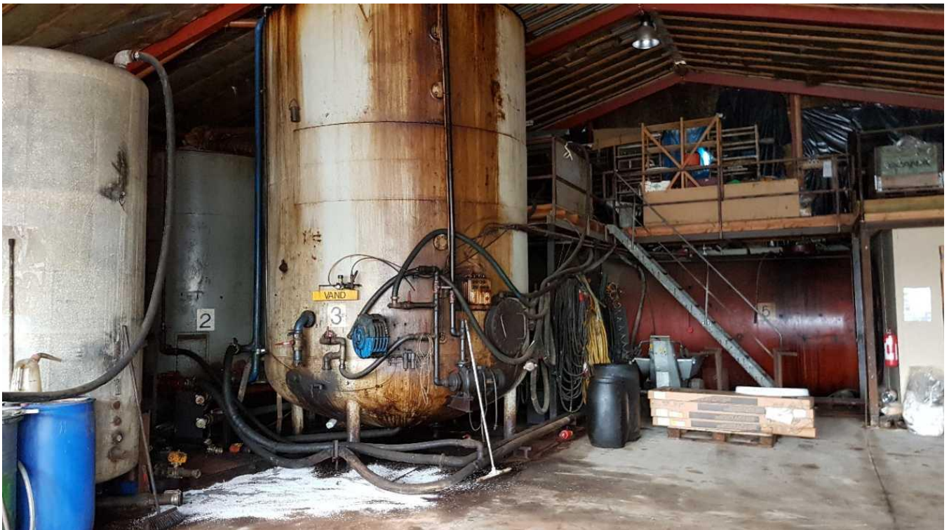
Olietanke i hal. Hallens sokkel og opkanter fungerer som spildbakke. Der er ingen afløb.
