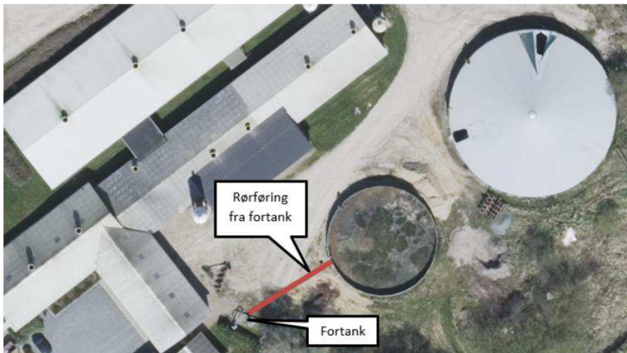
Figur 4 Rørføring fra fortank til gyllebeholder
