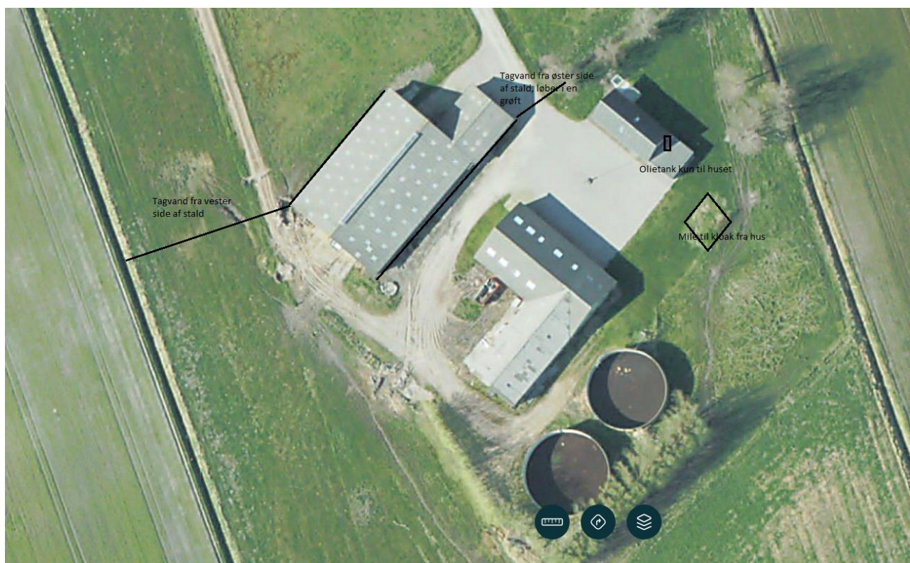
Afledning af tagvand fra staldanlæg
