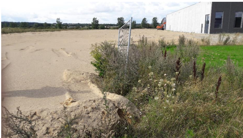
Foto 3. Slutafdækning på området sydøst for bygninger.
