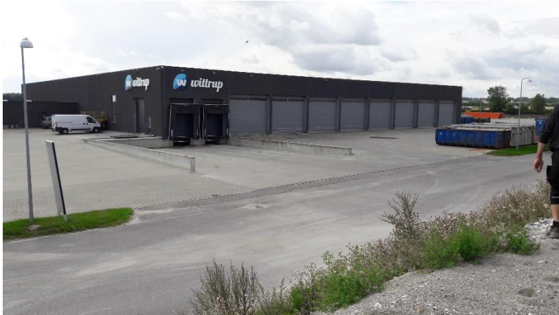
Foto 2. Befæstet område vest for Vittrup Seafoods bygninger.
