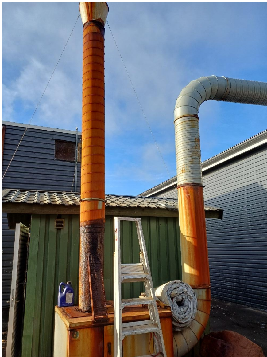
Tæring af 2-3 år gammelt afkast fra hal D
