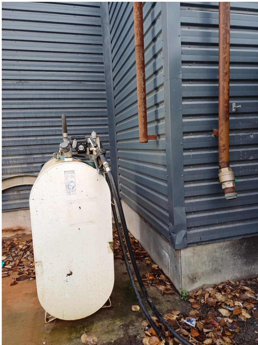
Tank med pistol, samt overløb og påfyldning af melasse til siloen i hal C
