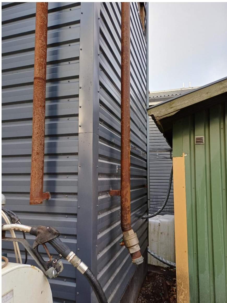
Metalskinne til prop for volumemåling i melassesiloen mellem skur og hal C
