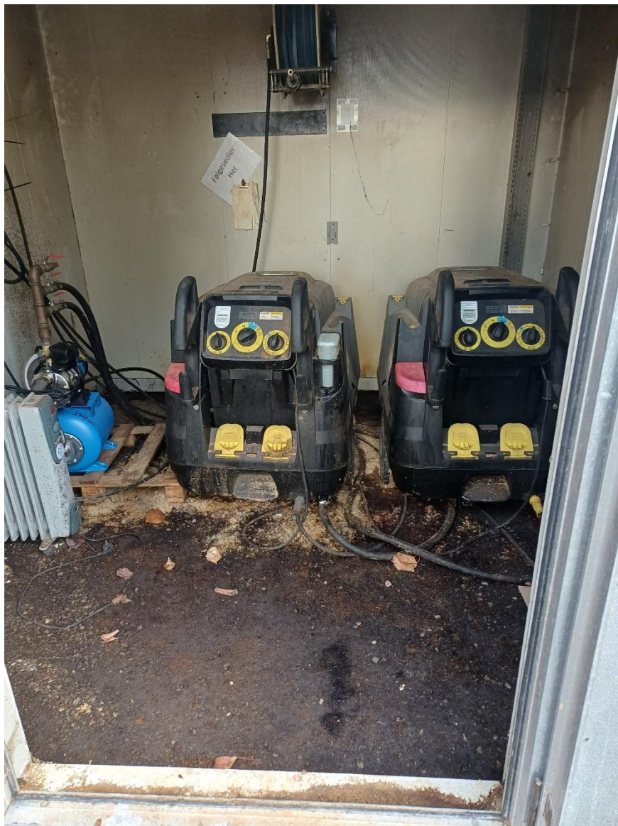
Tankplads under tag, men uden tæt belægning
