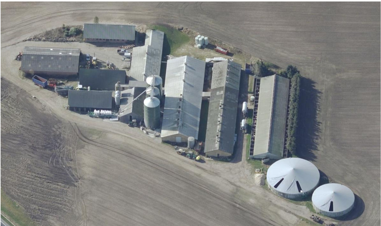
Figur 1. Oversigt over ejendommen som den ser ud i dag, set fra nord, hvor de eksisterende stalde, maskinhus, garage samt eksisterende gyllebeholder ses. Kilde: skraafoto.kortforsyningen.dk.
