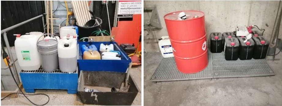
Billede 4. Oplag af diverse kemikalier og hydraulikolier på hhv. spildbakker med riste og på riste på betongulv afgrænset med en betonkant.
