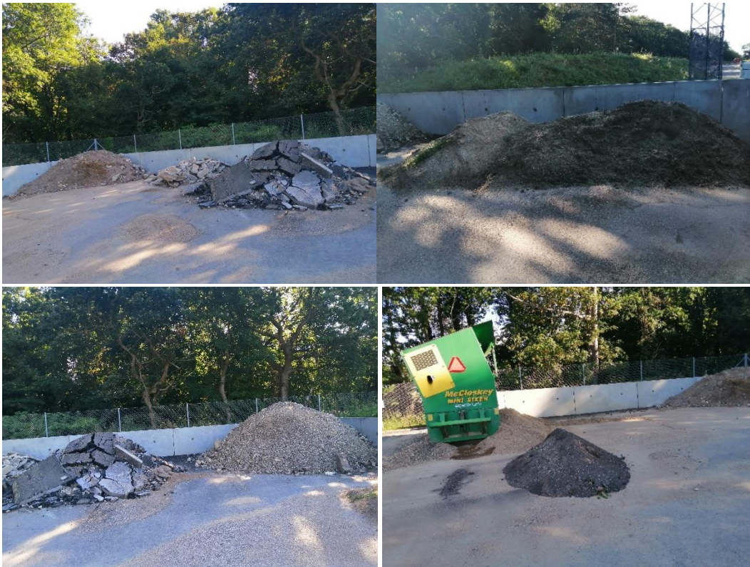
Billede 7 Mellemdeponi, oplag af asfalt, jord til genindbygning og beton.
