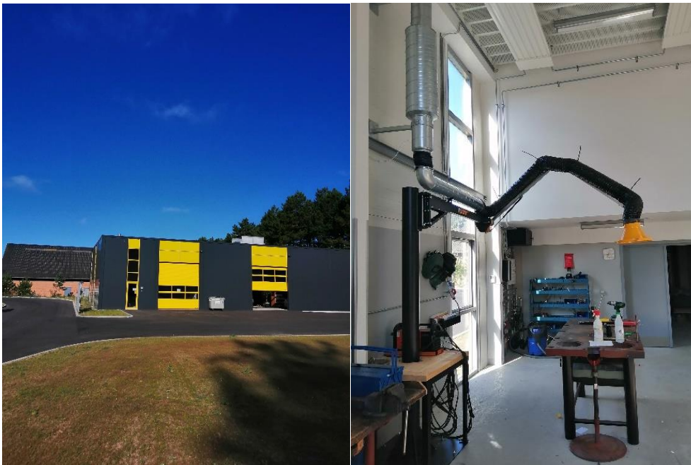
Billede 1 Ny lagerhal med nyt værksted. Punktudsug i nyt værksted (77 m 2 ).
