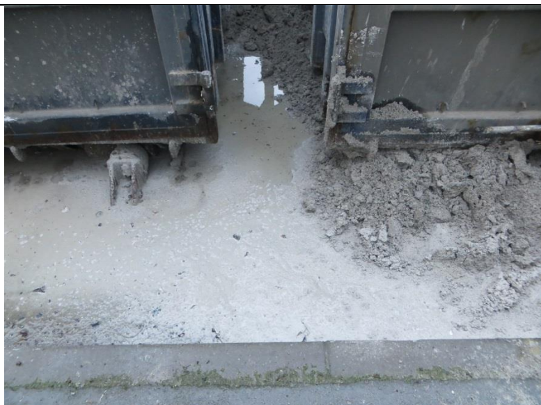
Spild ved slaggecontainerne.
