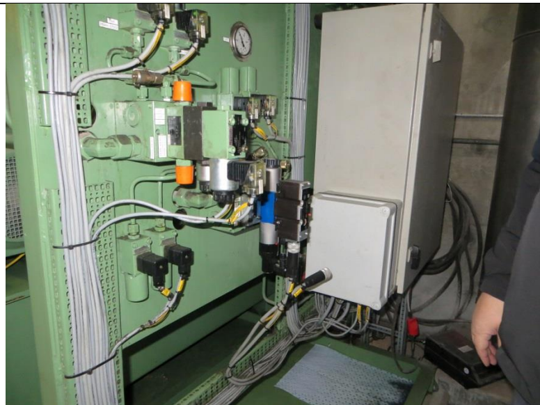
Den reparerede hydraulikstation, hvor der havde været problemer med oliedosering.
