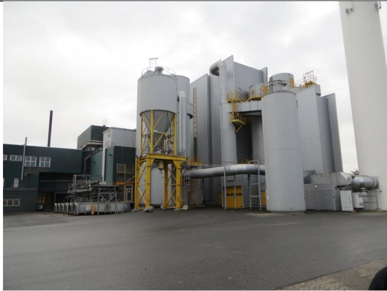
Forbrændingsanlægget set fra bagsiden med kalksilo til højre, aftapningssted for røggasrensningsprodukt i midten og slaggebånd med containere under til venstre.
