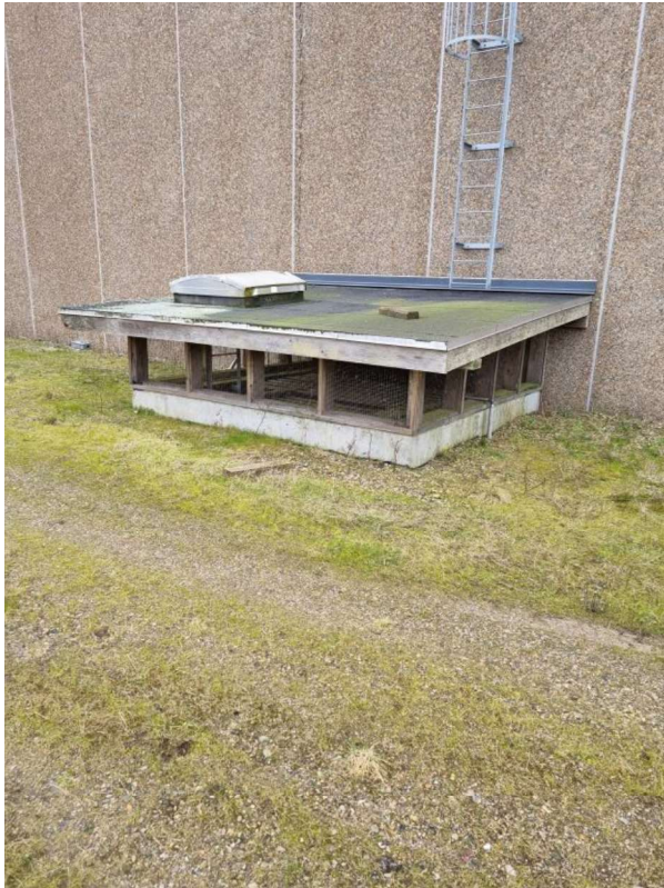
6. Indtag syd til beluftning hal 2007
