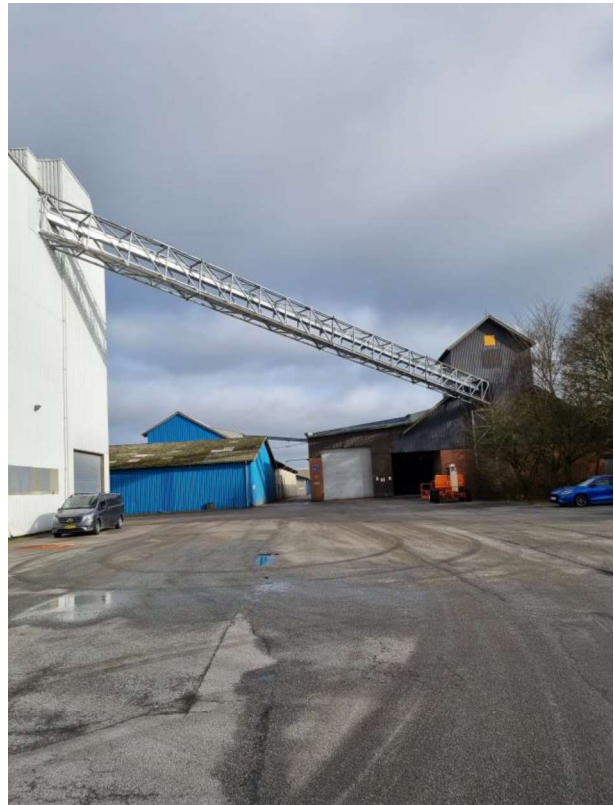
11. Redler til råvareindkørsel til fabrik
