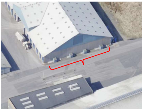
4 x Beluftning overfor brovægt
