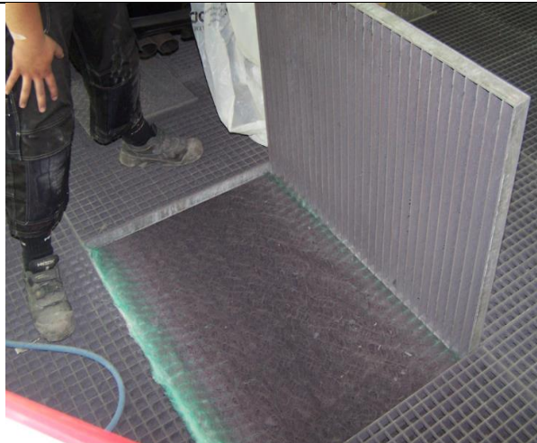
”Paint stop filter” der går fra væg til væg i sprøjtekabine
