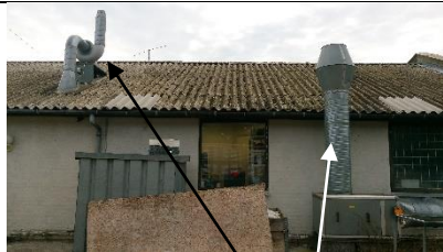
Billede nr. 3: Afkast fra rumventilation fra klargøring og blandebord
