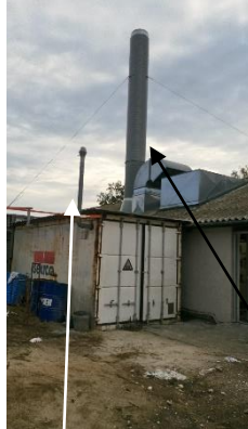
Billede nr. 1: Afkast fra malekabine og slibning
