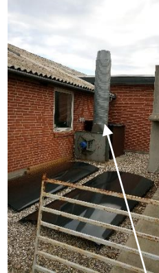
Billede nr. 2: Afkast fra rumventilation i sliberum
