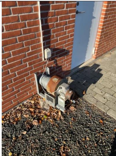
Billede nr. 5: Udsugning fra rensebar for spartler
