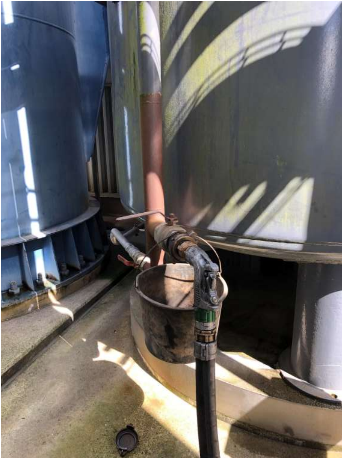
Billede 3: Opsamling af eventuelt under påfyldning.
