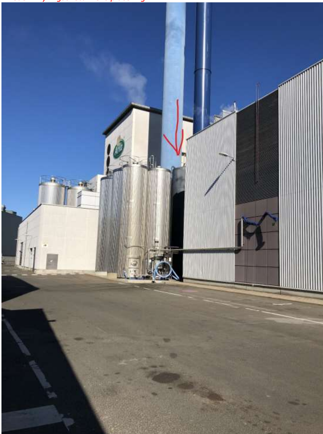
Placering af fyringsolietank (grå tank markeret med rød pil).
