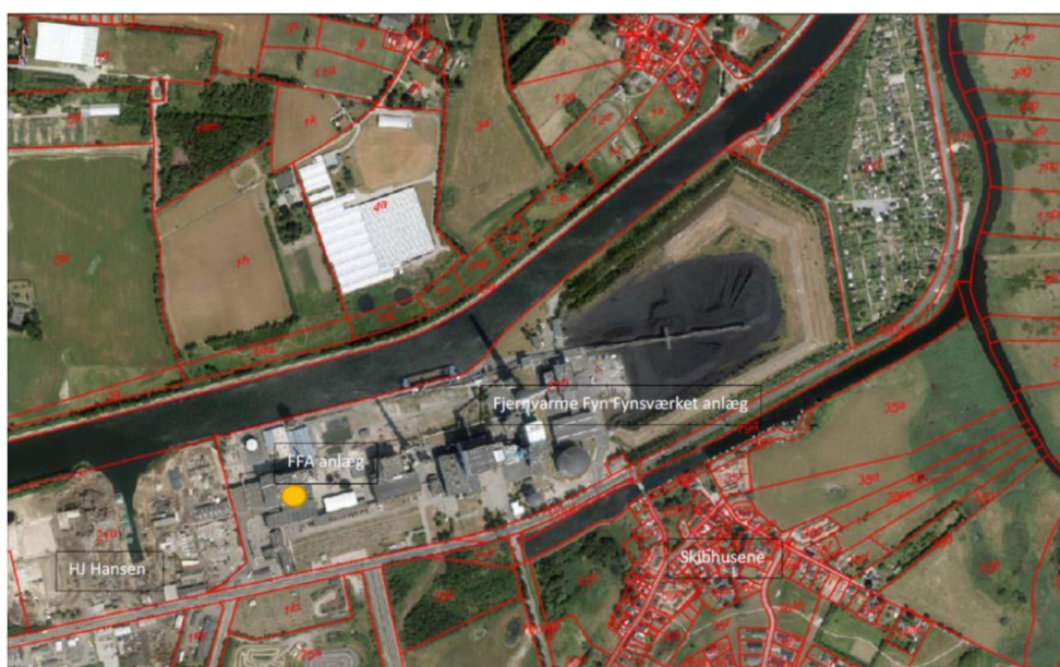
Placering af Fjernvarme Fyn Affaldsenergi
