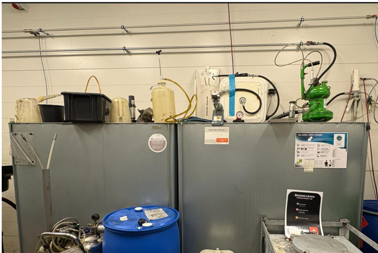
Billede 4. Tanken til venstre er til spildolie og den til højre er til frisk motorolie.
