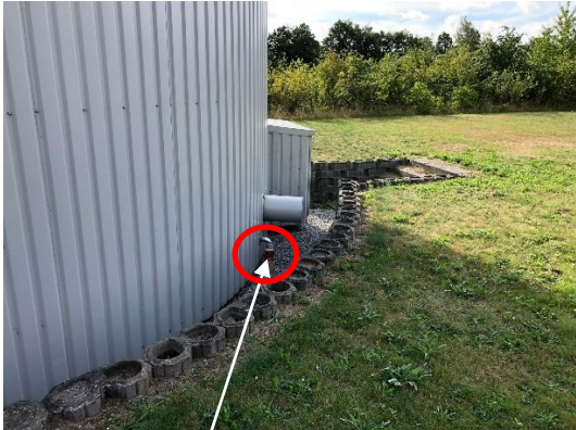
Billede nr. 10: Overløb fra akkumuleringsstanken
