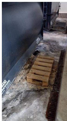
Billede nr. 7: Afløbsrist for vand fra askecontaineren (2022)
