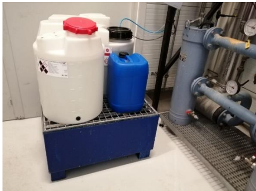
Billede nr. 9: Opbevaring af kemikalier til vandbehandlingsanlægget. (2022)
