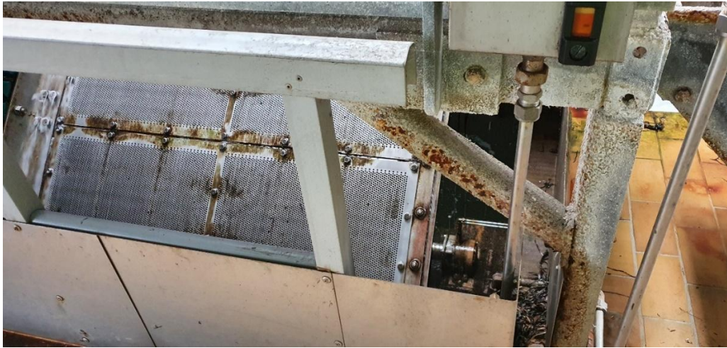
Figur 2-3. Billede af havvandsfilter i Renseværkbygningen.
