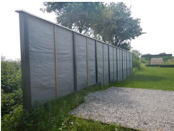
3. Nyrenoveret støjskærm ved 100 meter.
