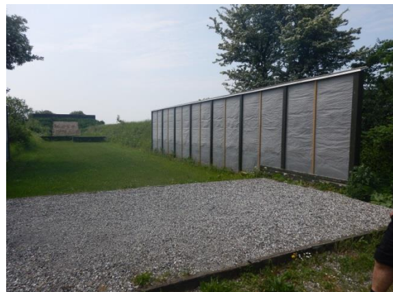
4. Nyrenoveret støjskærm ved 100 meter.
